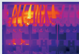
Svolgere la manutenzione degli impianti: rilevare temperature troppo alte dei fusibili o dei componenti elettrici prima che sia troppo tardi.
